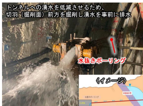
写真1 先進水抜き工状況
