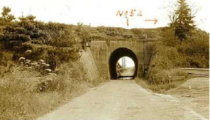
昭和26年頃の荒牧トンネル
