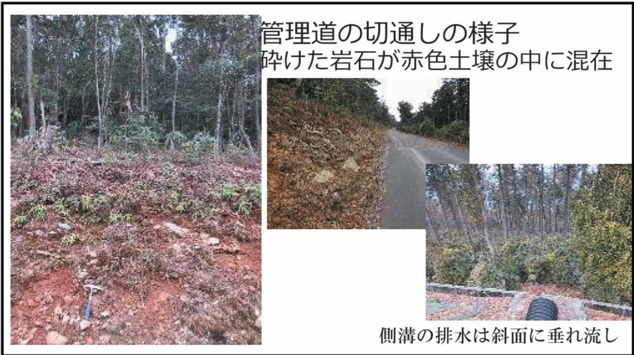
7号風車付近の稜線部で見つかった表層地質の完全露頭 風化した四万十層群砂岩の直上に赤褐色のアカホヤ火山灰層が分布
