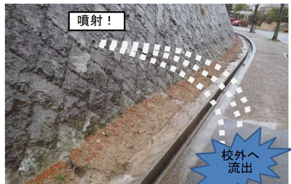
図-5 ブロック積からの噴射状況写真
