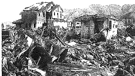
津波後の火災で惨憺たる状況
