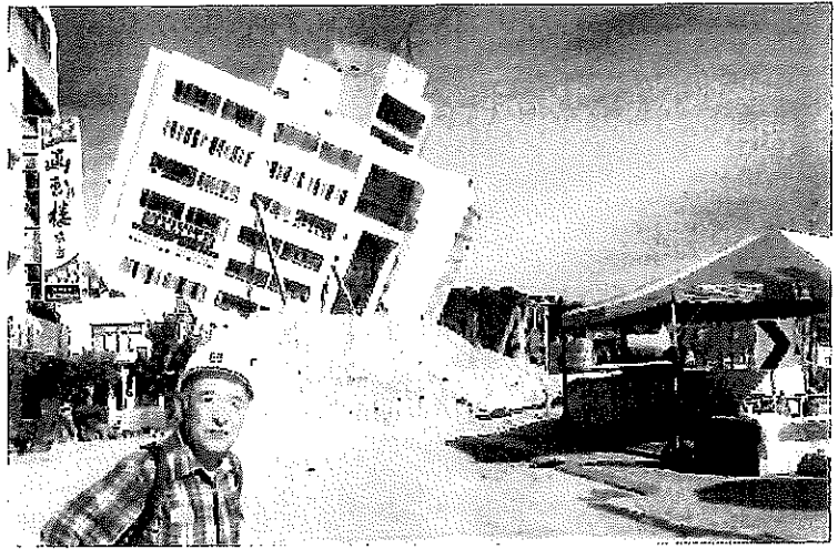
雲明翠大樓の解体工事 建物の周囲に砕石で盛土を行い、傾斜の進行による急激な倒壊を防止するとともに、上層階へ重機を接近させ、より安全な解体をめざしている。
