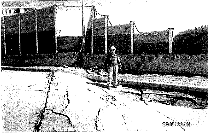
七星潭大橋の被害 2013年に完成した高架橋の路面にはひび割れが多数発生し、段差も生じた。橋端部にも被害が出ている（右上）。高架橋上側面が破壊されている箇所では直下に落石が積み上がっている（右下）。
