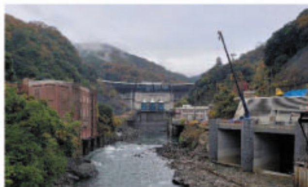
トンネル放流設備工事と天ヶ瀬ダム(2022)
