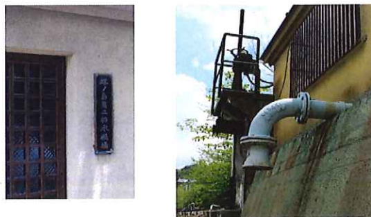
写真8 塔の島第二排水機場の自然排水口とポンプ排水口
