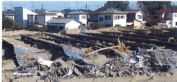
2015年9月10日台風17・18号 関東東北豪雨に伴う鬼怒川水害 太陽光施設のため掘削・無堤化した 常総市若宮戸地区 仮堤防が設置されている(撮影当時)
