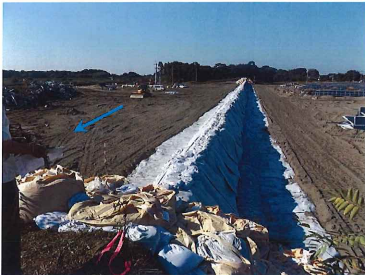
2015年9月10日台風17・18号 関東東北豪雨に伴う鬼怒川水害 太陽光施設のため掘削・無堤化した 常総市若宮戸地区 仮堤防が設置されている(撮影当時)
