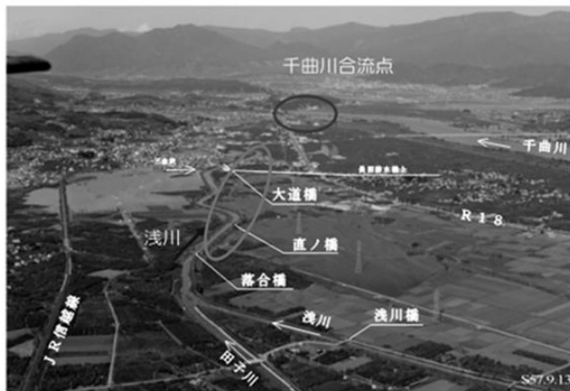
台風18号による浸水被害
