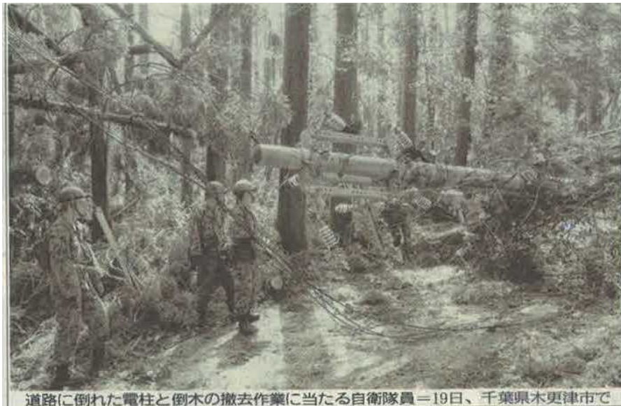
道路に倒れた電柱と倒木の撤去作業に当たる自衛隊員＝19日、千葉県木更津市で
