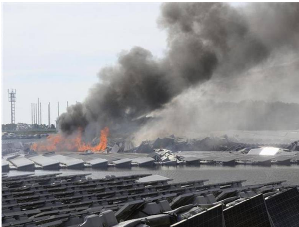
図10 市原市の山倉ダムの貯水地に設置された太陽光パネルの火災
