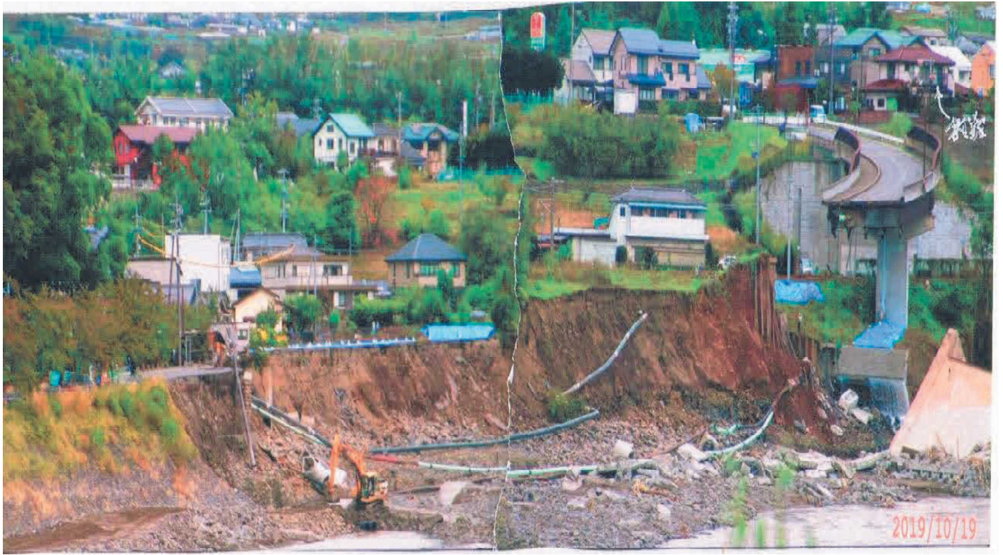
海野宿にカーブで下る道路橋、橋脚基礎が千曲川河畔に近接し、蛇行する水衝部。洗堀による河岸崩落と落橋。
