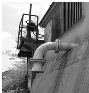
写真-8 塔の島第二排水機場の自然排水口とポンプ排水口
